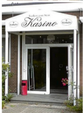
Der ehemalige Eingang ins Kasino. Foto: Stadt
