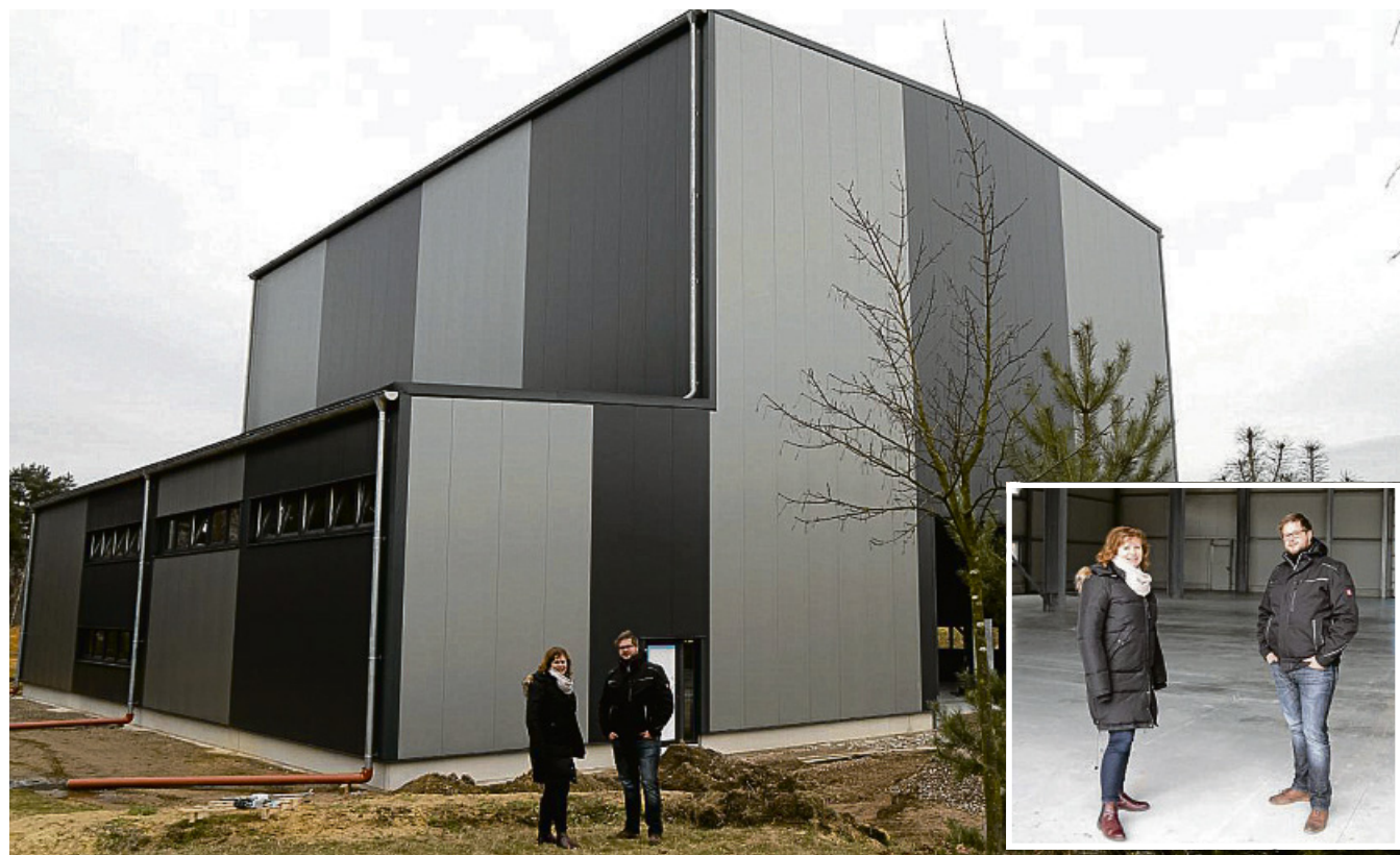
Im Januar wird die neue Montagehalle, die 17 Meter hoch ist, eingeweiht. Annette Görlich und Patrick Kostedde freuen sich über den großen Schritt der Firma Kostedde GmbH. Fotos: skm
